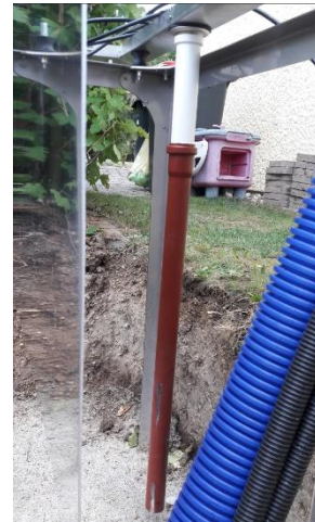
2. Kondensatanschluss montieren
