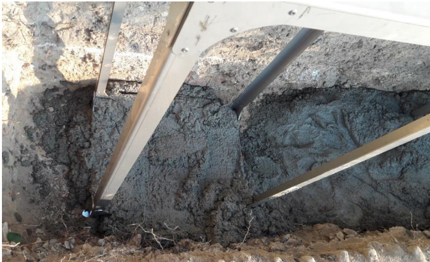
1. Konsole positionieren, ausrichten und mit 25cm Beton befestigen
