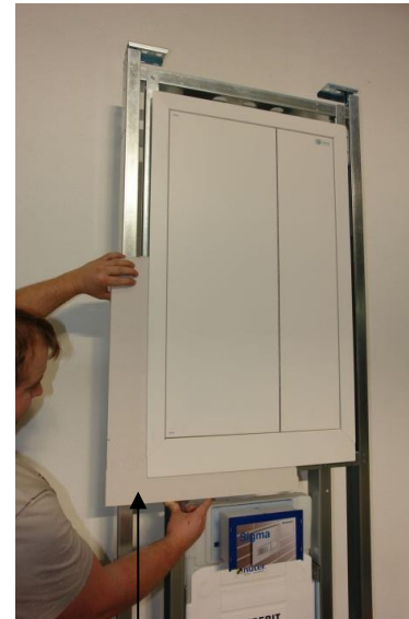
Lüftungsgerät in der Höhe und der Tiefe einstellbar (für einfach oder doppelte Beplankung)
